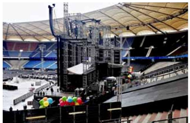
Daraus entstand die Gesamtkonstruktion – bestehend aus einem Gerüstsystem für die Bühnenbasis, Stahlbau für die Sonderteile und Traversen als Streckenmaterial. Die Custom-Megabühne wurde individuell nach den Designvorgaben geplant und neu produziert. Die nach Maß gefertigte Designbühne war rund 30 Meter hoch, 60 Meter breit und 25 Meter tief. In den Bühnenboden wurden
